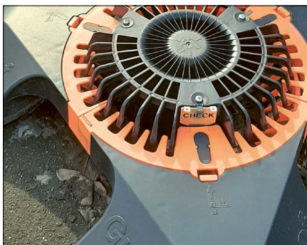
Bild 3: Der CHECK-Indikator (Bildmitte) zeigt an, dass der ROOFGUARD seit der letzten Wartung mindestens einmal aktiv für einen freien Ablauf gesorgt hat.
