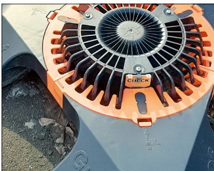
Bild 3: Der CHECK-Indikator (Bildmitte) zeigt an, dass der ROOFGUARD seit der letzten Wartung mindestens einmal aktiv für einen freien Ablauf gesorgt hat.
