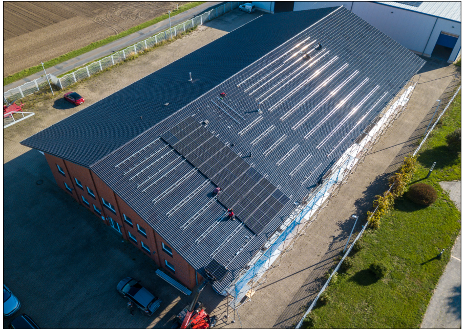
Bild 9: Rund 550 Quadratmeter Solarmodulfläche wurde insgesamt auf dem Steildach geschaffen.
