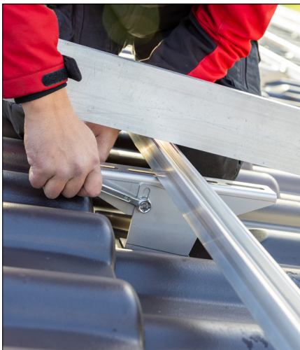
Bild 5: Die bereits werkseitig montierten Solarträgerstützen zur Aufnahme der Montageschienen lassen sich in der Höhe und Neigung justieren.
