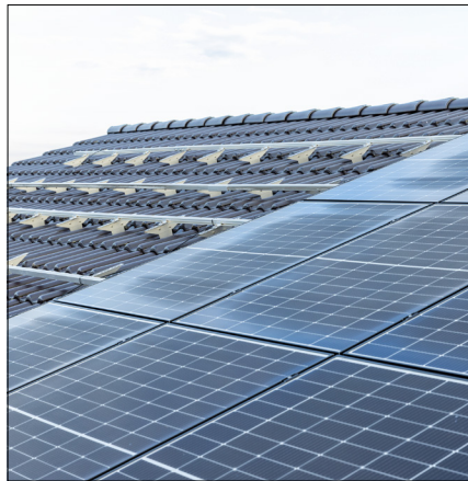
Bild 1: Auf dem Dach der Industriehalle sind 400 Solar-Trägerpfannen von FLECK zum Einsatz gekommen.
