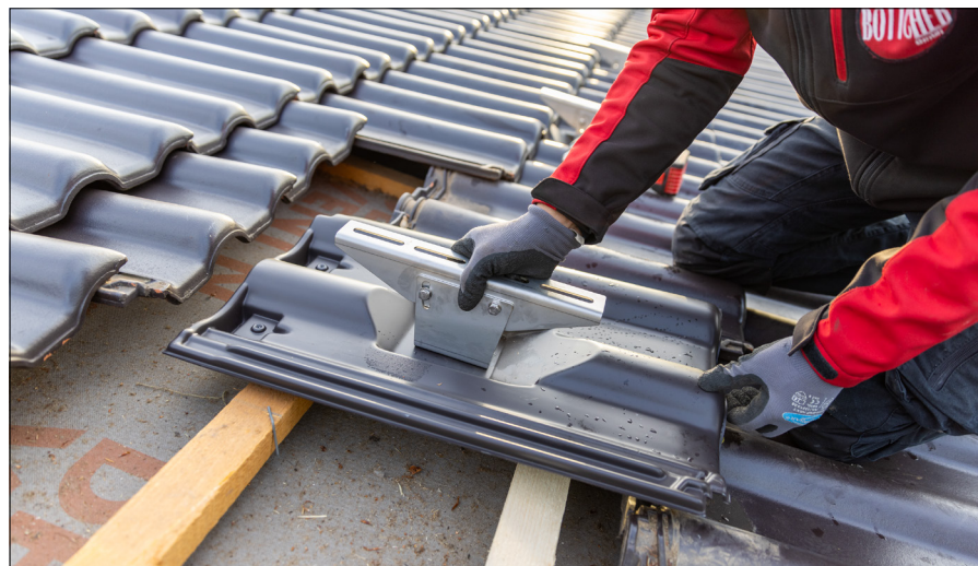
Bild 2: Dank der Formenvielfalt lassen sich die Solar-Trägerpfannen perfekt in die bestehende Dachfläche integrieren.
