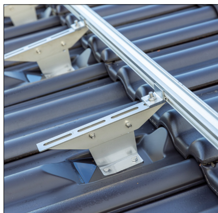
Bild 7: Die Schienen für die Unterkonstruktion werden über den Langlöchern ausgerichtet und mit passend zu wählenden Hammerkopfschrauben befestigt.
