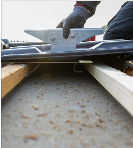
Bild 4: Das rückseitig angebrachte Z-Profil sorgt für eine optimale Windsogsicherung. Gut zu sehen ist hier die im vorgegebenen Abstand gesetzte und statisch erforderliche Zusatzlatte.
