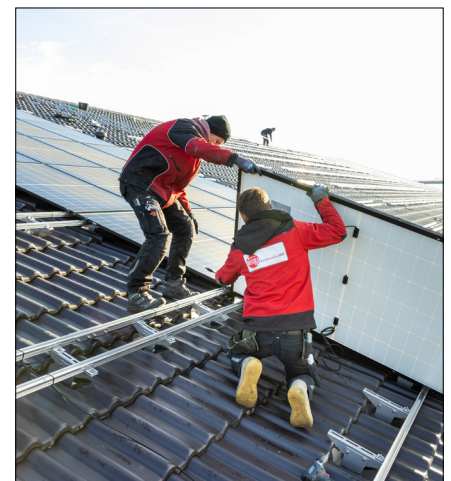
Bild 8: Die Solarmodule lassen sich danach gut auf der ausgerichteten Unterkonstruktion verlegen.
