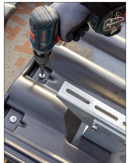
Bild 3: Die FLECK Solar-Trägerpfannen werden einfach mithilfe von zwei handelsüblichen Spenglerschrauben, die bereits im Lieferumfang enthalten sind, an der Dachlattung befestigt.
