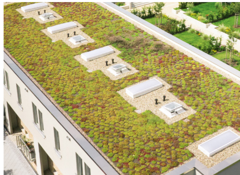
FLECK biedt oplossingen voor gecontroleerde ontwatering, luchtverversing en ontluchting, doorvoer van leidingen en kabels alsmede inspectie.
