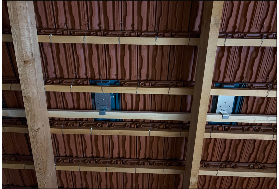
Bild 2: Mithilfe des rückseitig angebrachten Z-Profils aus verzinktem Stahl wurden die Solar-Trägerpfannen einfach in die zusätzlich angebrachte Dachlatte eingesteckt und verschraubt.
