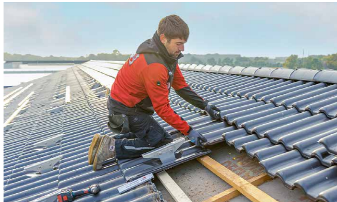
Die FLECK Solar-Trägerpfanne mit einstellbarer VA-Halterung ermöglicht die sparrenunabhängige und sichere Montage von Solaranlagen auf Schrägdächern.
