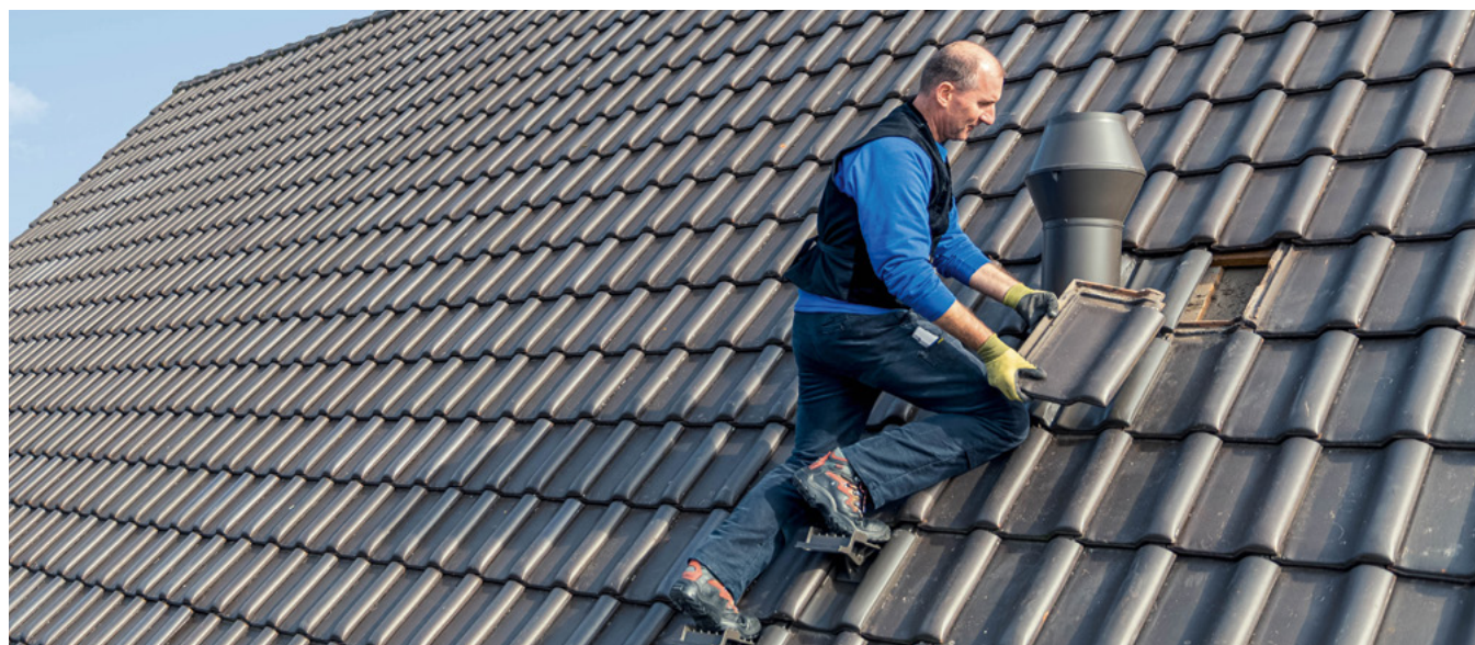
Einbau eines Wrassenlüfters mit Flairkopf – eine sichere Sache mit dem Sicherheitstritt von FLECK.
