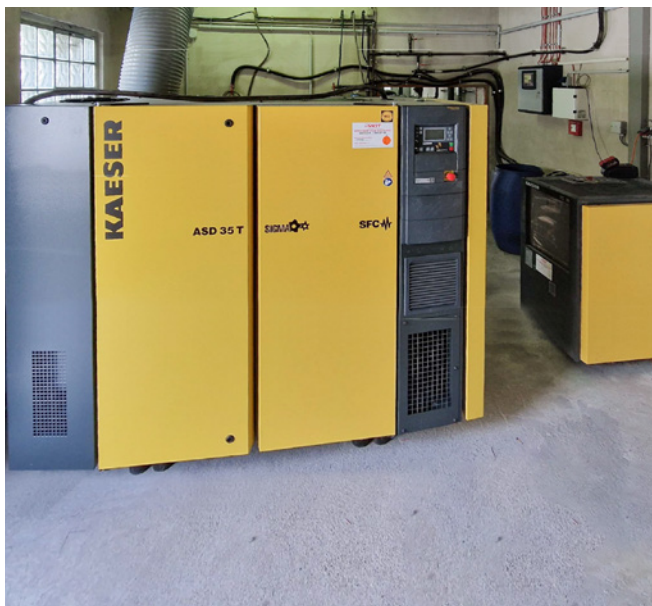
Die Heizungsanlage wurde modernisiert und mit einer Wärmerückgewinnung ausgestattet.
