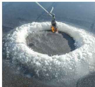
2 Oberfläche mit Brenner trocknen
