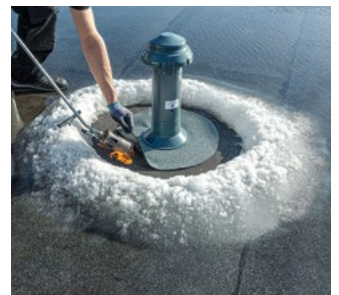
4 Schweißarbeiten durchführen
