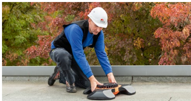
Der ROOFGUARD lässt sich ohne großen Aufwand auf fast jedem Flachdach installieren.
