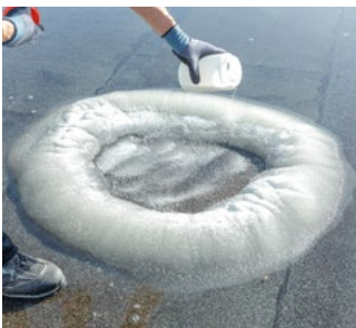
1 ROOF SUPER DRY ausstreuen
