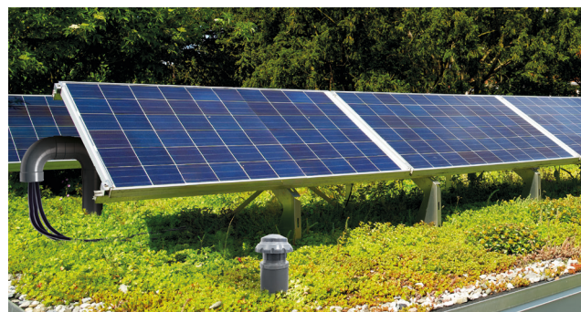
Combinaison d'un toit vert et d'une installation photovoltaïque surélevée.
