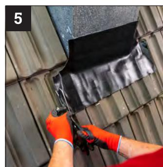
Die seitlichen Überstände über Eck führen und am Bauteil sowie im unteren Bereich an die Dachpfannen anarbeiten. Überschüssiges Material sauber abschneiden.
