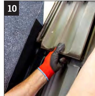
Aufgedeckte oder hochgescho- bene Dachpfannen auf den ange- arbeiteten ECO FORM Schicht- stücken korrekt eindecken.
