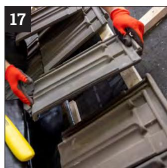
Das Dachumfeld danach komplett eindecken. Bei zu geringer Über- deckung durch die Dachpfannen kann mit einem weiteren Streifen ECO FORM verlängert werden.
