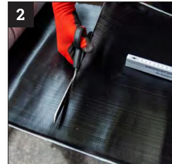
Das Bruststück aus ECO FORM Stück passend zuschneiden (z. B. mit einer geeigneten Schere).
