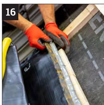
Schutzfolie entfernen und die ECO FORM Kaminkehle firstseitig an das Bauteil kleben. An der freien Oberkante zur Stabilisierung einen ausreichenden Wasserfalz aus- bilden.
