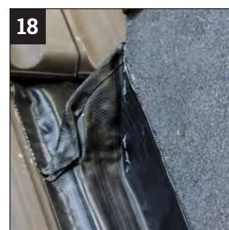
Die Eckbereiche der Kaminkehle (z.B. mit einer Schere) etwas abrunden. Dann, wie hier zu sehen, mit den zuvor erstellten Seitenlaschen sorgfältig und mit Gefälle verfalzen. So kann Regenwasser später sicher abfließen.
