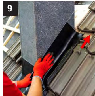
Obere Dachpfanne ggf. aufdecken oder hochschieben. Weitere Schichtstücke analog zu Einbauschritt 8 anbringen.
