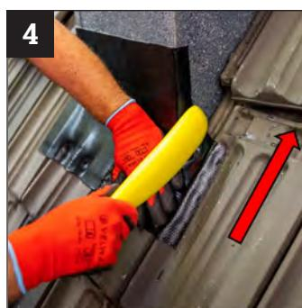
Bei Bedarf angrenzende Dachpfannen aufdecken oder hochschieben. Das ECO FORM Bruststück mit geeignetem Werkzeug dicht an den Untergrund anarbeiten.
