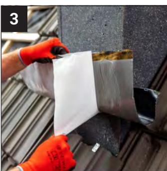
Mittig geteilte Schutzfolie erst oben abziehen und das ECO FORM Bruststück am Bauteil ansetzen. Den unteren Bereich zunächst handisch an die Umgebung anformen, dann Schutzfolie entfernen.
