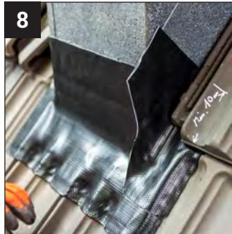
Den oberen Teil der rückseitigen Schutzfolie abziehen und das Seitenteil passgenau ansetzen. Den 2. Teil der Schutzfolie abziehen und ECO FORM an die Dachpfanne anformen.
