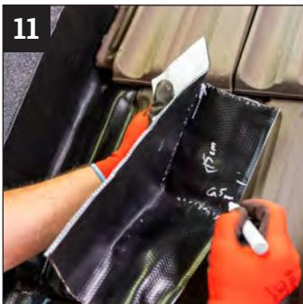
Das oberste Schichtstück der Seiteneinfassung, wie auf der Abbildung gezeigt, vorbereiten. Empfohlen: Überdeckung nach oben mind. 15 cm und seitlich mind. 5 cm.
