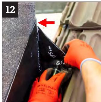
Nun das Schichtstück, oben eingeschnitten, über Eck führen. Die Folie entfernen und das Stück (oben) an Bauteilrückseite und unten an die Dachpfanne kleben.
