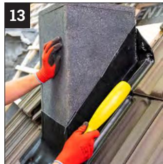
Das oberste Schichtstück mit geeignetem Werkzeug an den Untergrund anarbeiten.
