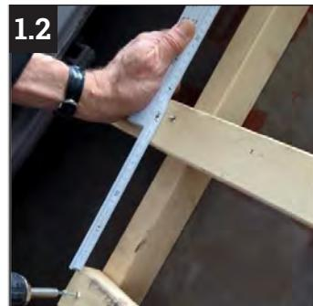
1.2 Das Dachumfeld nach Bedarf abdecken. Ansetzen der Zusatzlatte gemäß der Lattmaßangabe "Z" und Verschrauben mit der Konterlattung.
