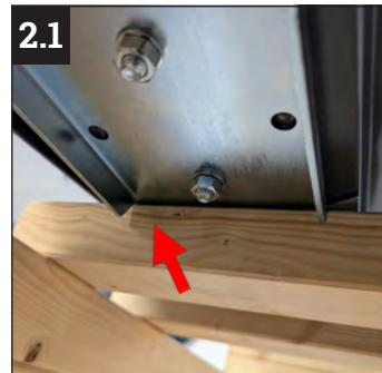
2.1 Kombi-Schneefangpfanne in die Dachlatte einhängen und Positionierung prüfen. Korrekter Sitz: das seitlich abgekantete Stahlprofil endet kurz vor der Zusatzlatte.
