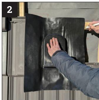
Tipp: Die optimale Ausrichtung sichtbar auf der Lattung markieren.
