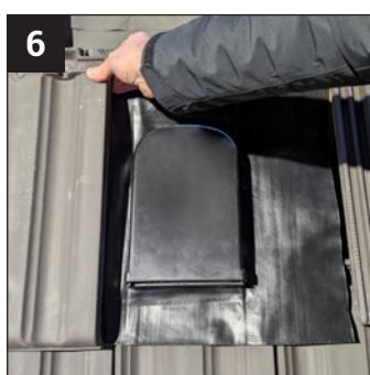
Die links benachbarte Dachpfanne anheben und den Falz darunter fachgerecht einbetten. An der Oberkante einen weiteren Falz formen.
