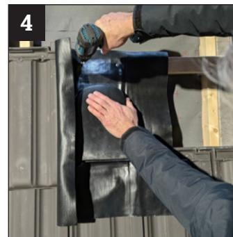
Manschette mit 2 Spenglerschrauben (oder Schrauben mit Dichtring) an der Dachlatte fixieren.
