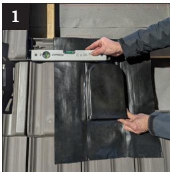
Korrekte Position einmessen. Darauf achten, dass die Dachpfanne darüber später nicht auf der Abdeckung „aufsitzt“.
