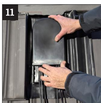
Die Abdeckung in der richtigen Position aufsetzen (siehe Abb. 9) und durch Herunterschieben verschließen.
