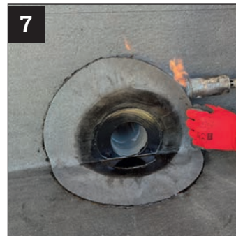
7 Thermische Fixierung der Flanschmanschette auf der ersten Bitumenlage.
