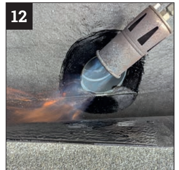
12 Es folgt die thermische Fixierung der 2. Oberlage. Die untere Dachbahn, wie abgebildet, dicht bis an die aufgehende Wand heranführen und fachgerecht verschweißen.
