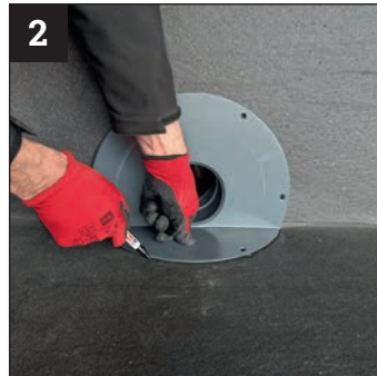
2 Markierung der unteren Flanschkontur auf der Fläche.
