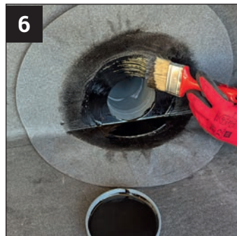
6 Fachgerechte Vorbehandlung des PVC-Flansches mit geeignetem Bitumenvorstrich.
