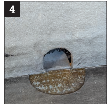
4 Fertig vorbereitete Einbausituation.
