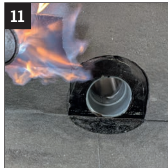
11 Dichtes Verschweißen der von oben kommenden 1. Oberlage.
