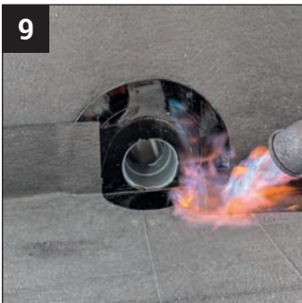
9 Es folgt die thermische Fixierung der 1. Oberlage. Die Bahn, wie abgebildet, dicht an der aufgehenden Wand hochführen und fachgerecht aufschweißen.
