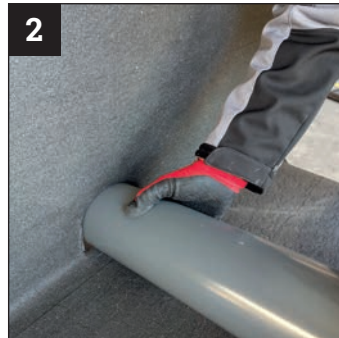
2 Zunächst nur loses Einsetzen des Winkelablaufs in die entsprechend vorbereitete Öffnung in der Attika.
