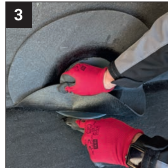
3 Markieren und Ausschneiden der PVC-Flanschdeckelkontur aus der ersten Bitumenlage.
