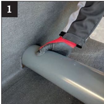
1 Einsetzen des Ablaufs in die entsprechend vorbereitete Öffnung in der Attika und ggf. mechanisch fixieren.
