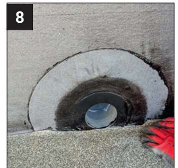
8 Es folgt die thermische Fixierung der Oberlage. Die Bahn, wie abgebildet, dicht bis an die aufgehende Wand heranführen und fachgerecht aufschweißen.
